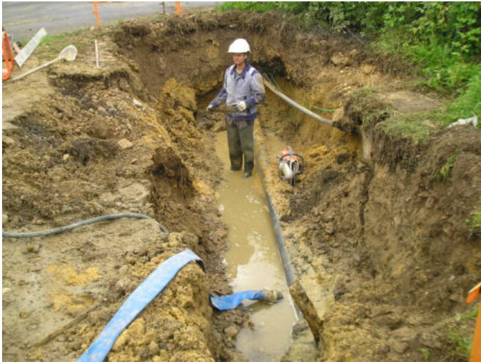
Remise en état du réseau d'eau à Roseau Plage par la SAUR.
