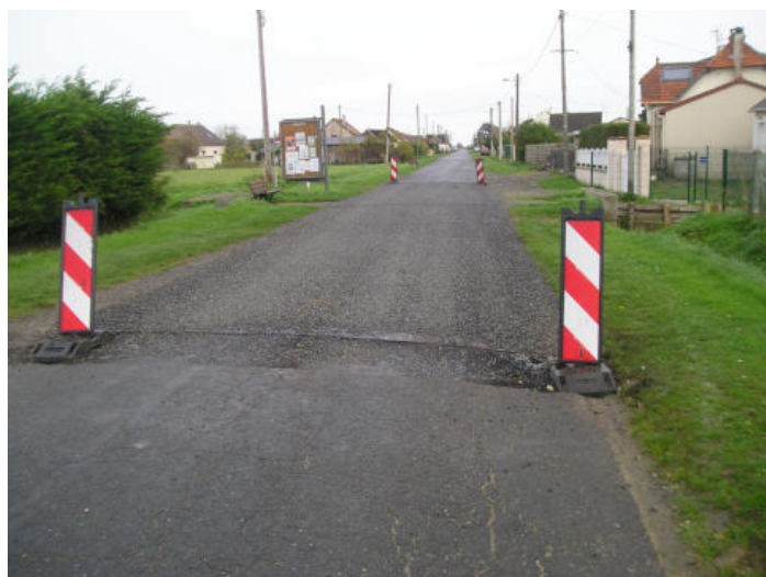
Réfection du pont enjambant la Gronde rue du Dorset Regiment effectuée par l'entreprise Martragny, sous maîtrise d'ouvrage S.T.M.
