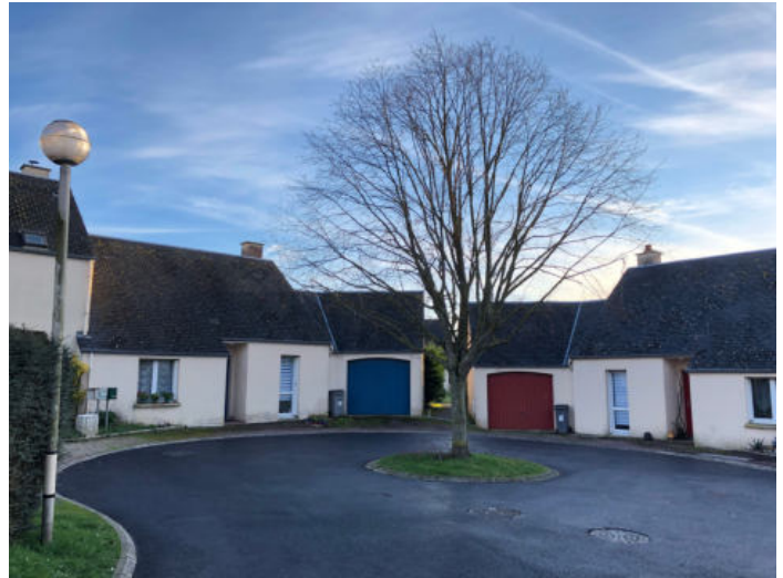
Remise en état de la voirie square du Bas Colombier, par l'entreprise Martragny, sous maîtrise d'ouvrage S.T.M.
