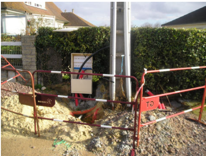
Enfouissement des réseaux et pose de quatre nouveaux candélabres rue de la Marine.
