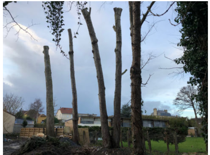
Par mesure de sécurité, les arbres situés derrière les locaux des services techniques ont fait l'objet d'un élagage par l'entreprise E.T.A.G.F.
