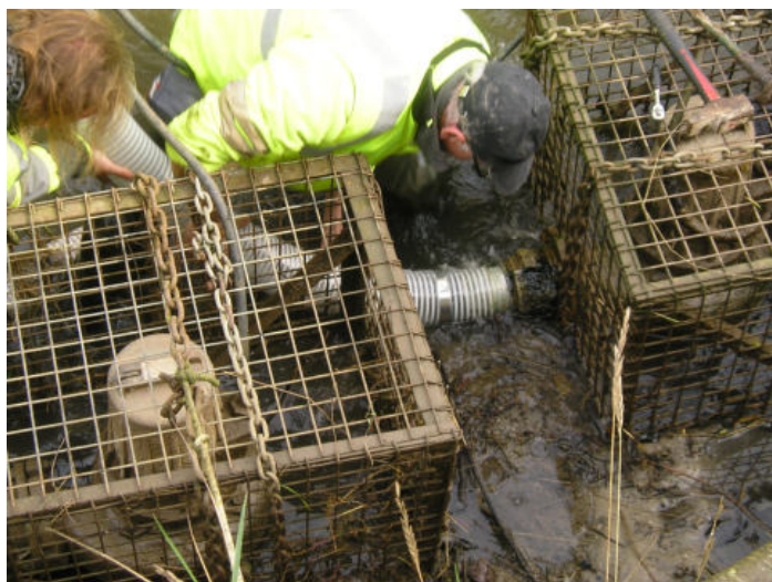
Remise en état du système de pompage de la Gronde à hauteur des vannes de l'émissaire ouest du fleuve côtier, par les services techniques de la commune.
