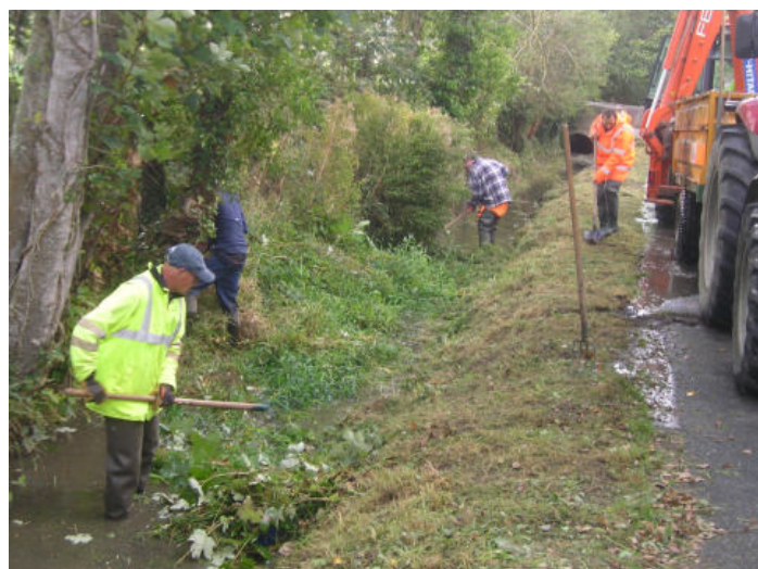
Curage de la Gronde par les services techniques de la commune.
