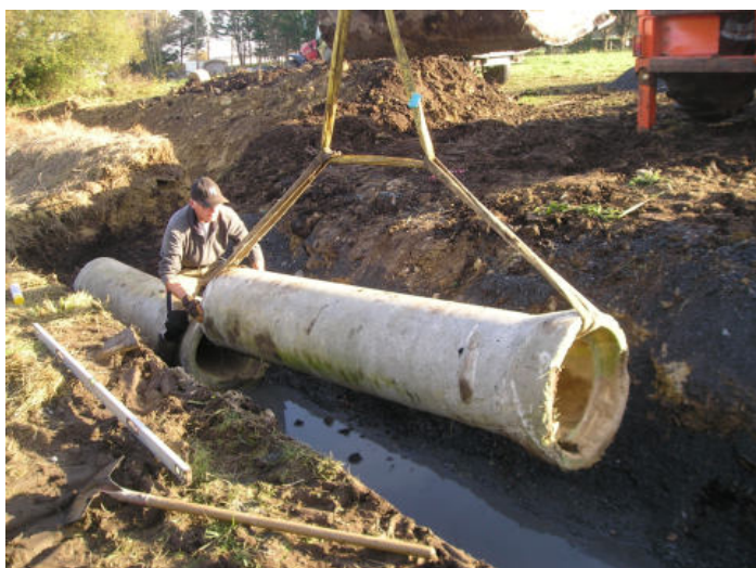
Remise en état et busage d'un fossé d'eau pluviale le long de la résidence de l'Odyssée, par les services techniques de la commune.
